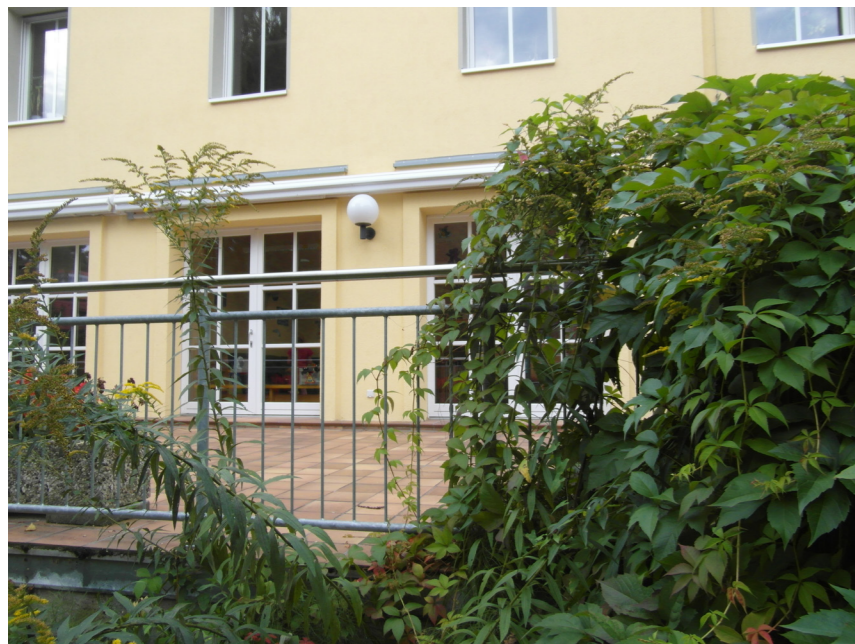
Foto: Anschlussfläche für den Wintergarten über zwei Fenstertüren oberhalb der Markise
